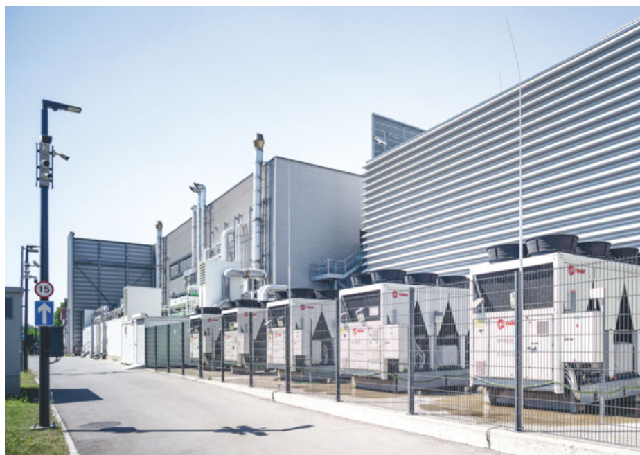
Cinq machines frigorifiques maintiennent la température du centre ZH5 d'Equinix en dessous de 27 °C.
