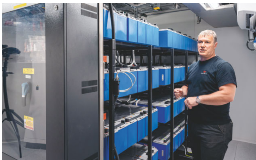
En cas de panne de courant, l'exploitation continue de fonctionner à plein régime pendant 32 heures. Roger Beeler dans la salle des batteries.
